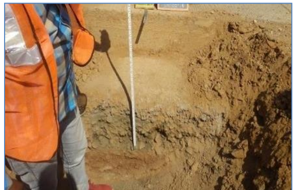
km 205.200 RHS (GMP-TP-16)
