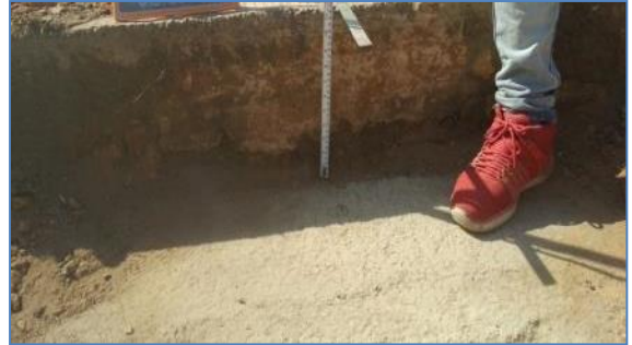
km 155.400 RHS (GMP-TP-6)
