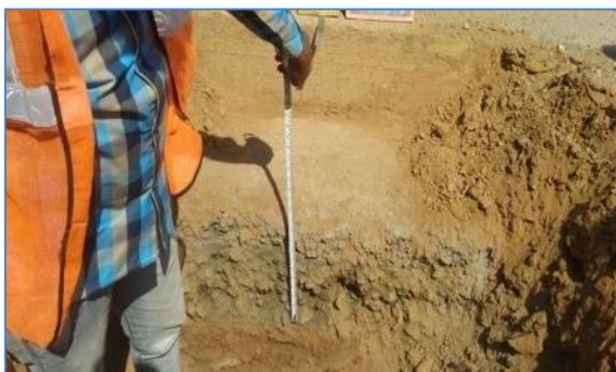
km 205.200 RHS (GMP-TP-16)
