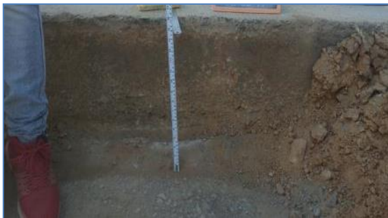
km 143.200 RHS (GMP-TP-4)
