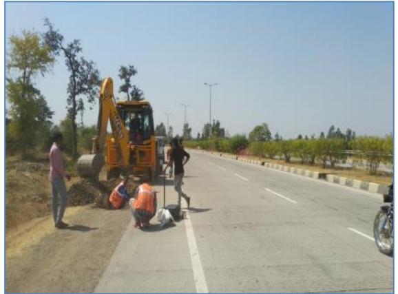
km 174.400 RHS (GMP-TP-10)
