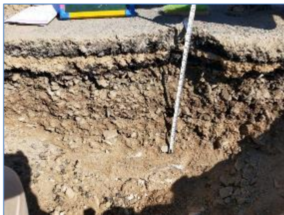
km 365+000 RHS (JP-TP-11)
